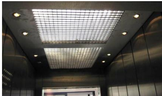
Abbildung 63: Kabinenbeleuchtung Aufzüge
