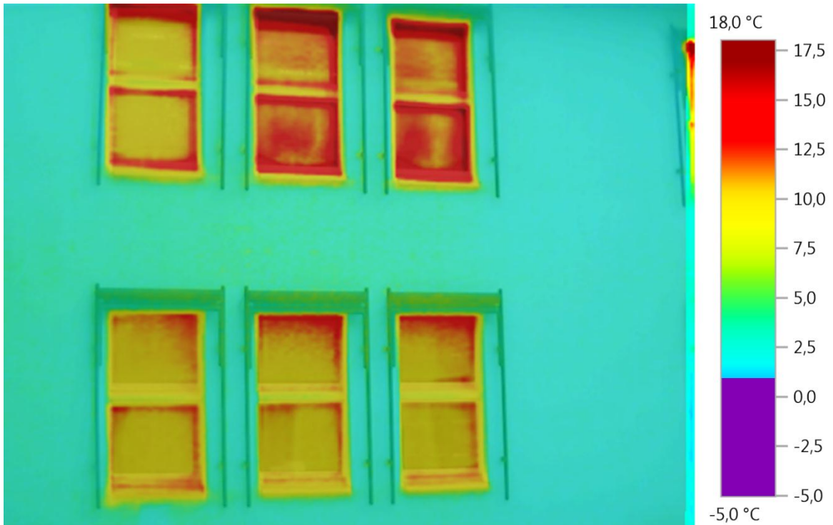
Abbildung 3: Wärmebildaufnahme der Außenwand
