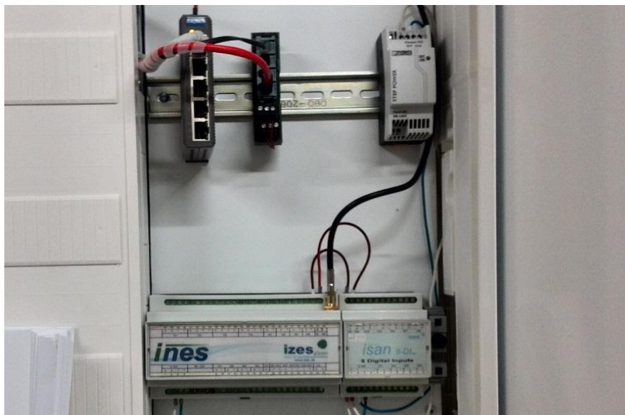
Abbildung 115: INES-Box mit ISAN-Erweiterung
