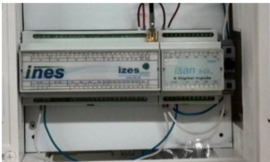
Abbildung 124: INES-Box mit ISAN Erweiterung
